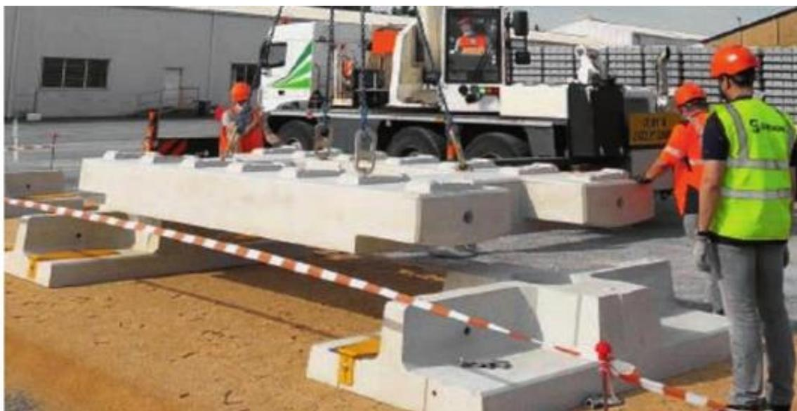
Французские компании SYSTRA и STRADAL (специализируется на конструкциях из сборного железобетона) показали на выставке разработанную совместно новую конструкцию безбалластного пути, которая пригодна для линий всех типов – от высокоскоростных и пригородных до грузовых.
