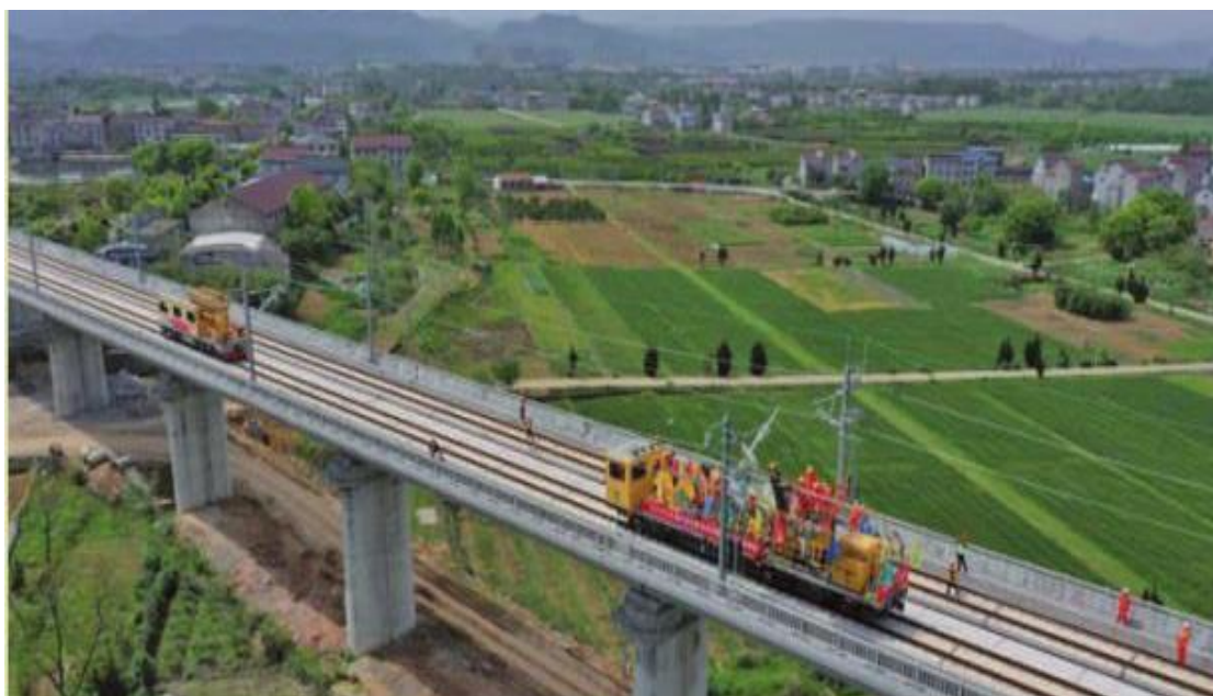
Работы по монтажу контактной сети
